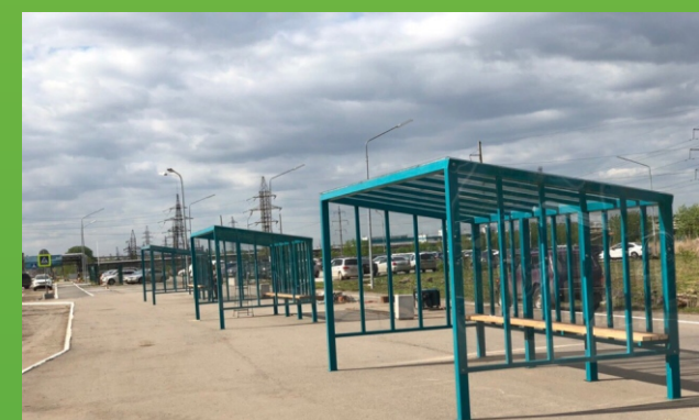
Остановочный комплекс ПАО «Сибур», ул. Промышленная
